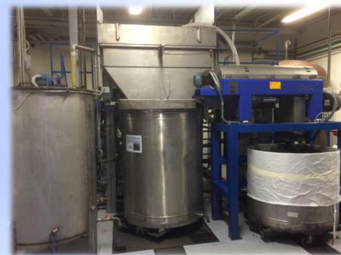
Sistema trattamento acque
